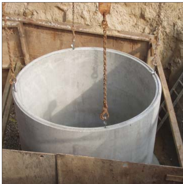
Levering af IBF Fiberbetonbeholder, bundsektion.
